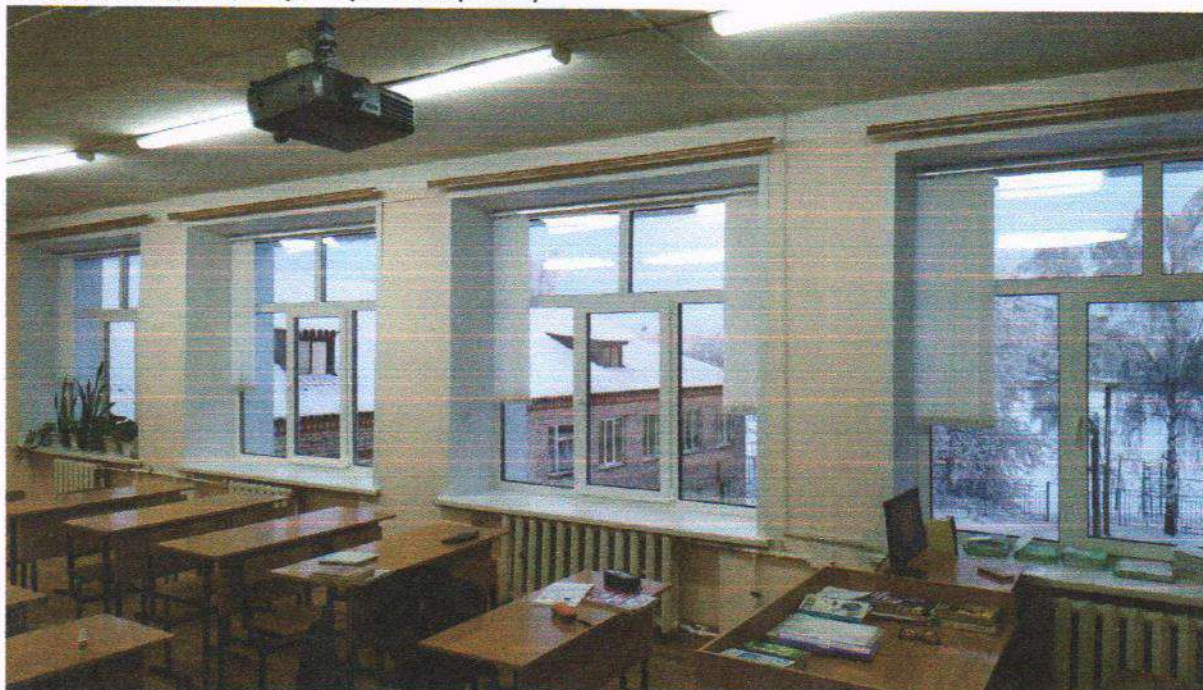
Приложение 5 (окна учебных кабинетов химии, оснащены регулируемыми солнцезащитными устройствами, линолеум отремонтирован)
